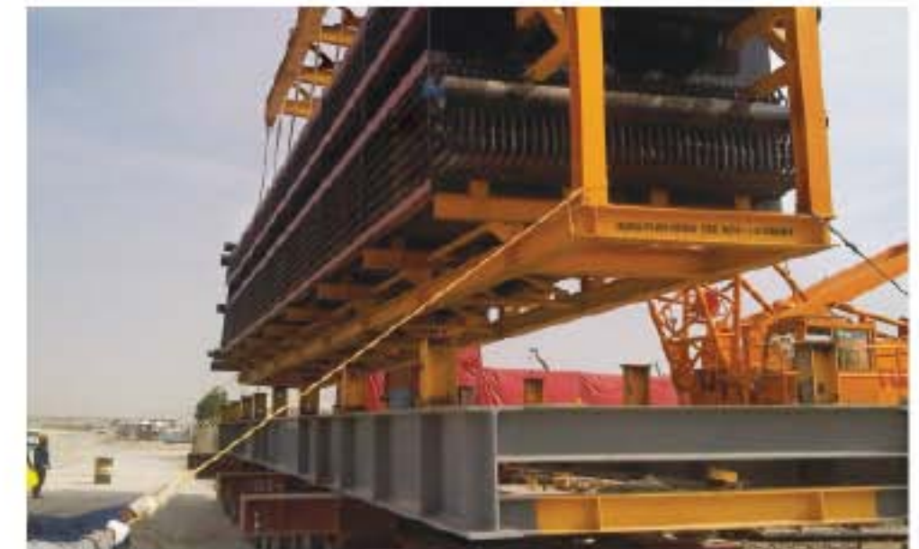
HRSG module being lifted
